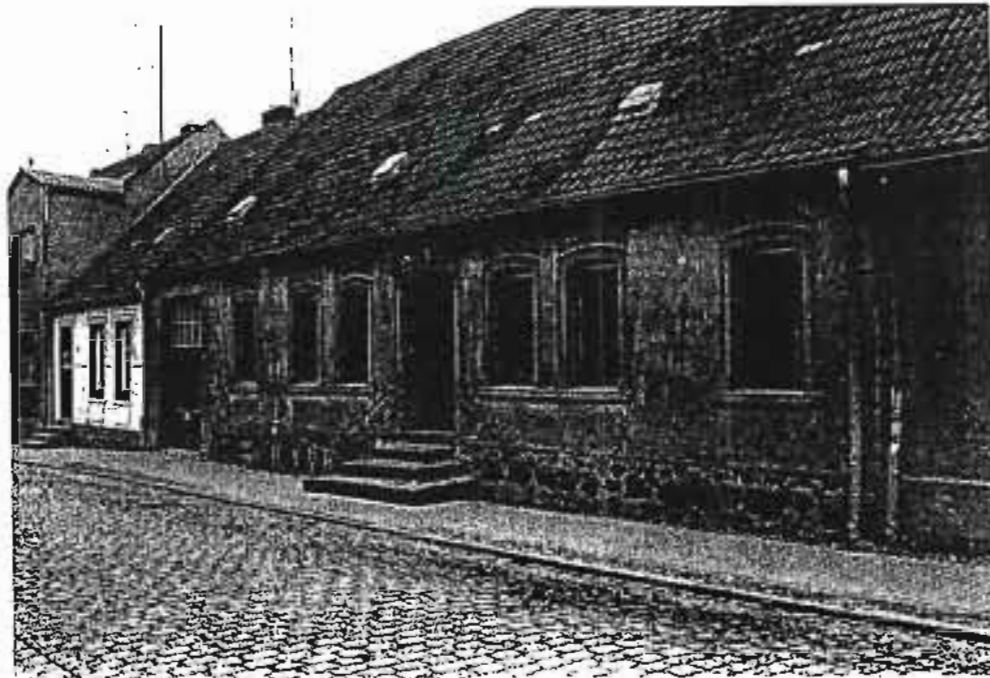
Gutes Beispiel von verputzter Hausfassade und Granitsockel
