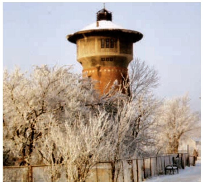
Foto rechts: Der Wasserturm in Löcknitz (hier noch vor der Rekonstruktion) fasste laut einer Übersicht von 1947 25 Kubikmeter Wasser und kündigt noch heute, als Lost Place, von den Eisenbahntraditionen in der Randowgemeinde.
