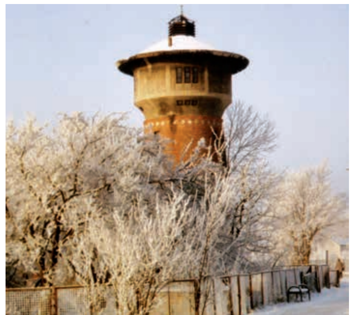
Foto rechts: Der Wasserturm in Löcknitz (hier noch vor der Rekonstruktion) fasste laut einer Übersicht von 1947 25 Kubikmeter Wasser und kündigt noch heute, als Lost Place, von den Eisenbahntraditionen in der Randowgemeinde.
