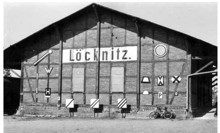
Zur Eisenbahntechnischen Ausstellung, veranstaltet durch das Verkehrsmuseum der DDR in Dresden, war der heute nicht mehr vorhandene Löcknitzer Güterschuppen durch allerlei Signale und Warnzeichen verschiedener Eisenbahnepochen geschmückt worden, Erinnerungen an die Prenzlauer Kreisbahn und die große Zeit von Löcknitz als Bahnknoten.
