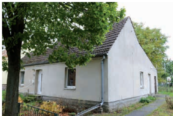
Ansicht von der Dorfstraße
