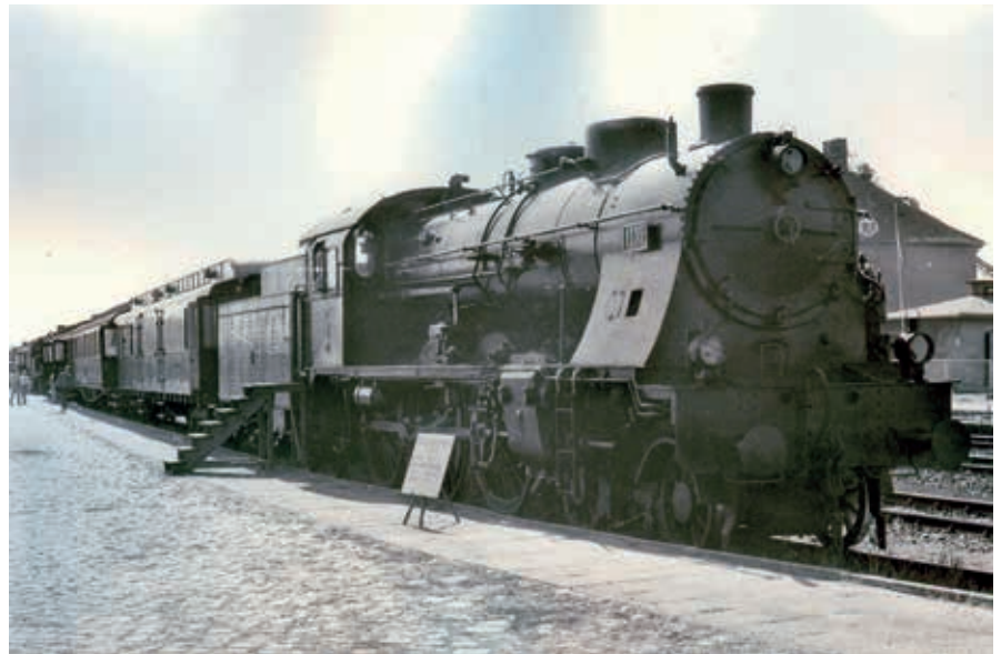
Zum 125. Jahrestag der Inbetriebnahme der Strecke Stettin-Pasewalk 1988 war in Löcknitz während einer DR-Fahrzeugausstellung auch die Lok 17 1055 zu sehen. Loks dieses Typs waren auch vor Schnellzügen im Jahre 1914 im Einsatz.
