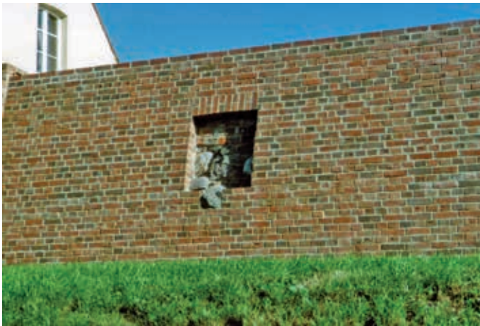
Detail aus den sanierten Teilen der ehemaligen Festungsmauer. Die Festung Löcknitz hat so einige Kanonaden über sich ergehen lassen müssen und war lange Jahre ein wichtiger Punkt in den polirischen Kombinationen der Hohenzollern.
