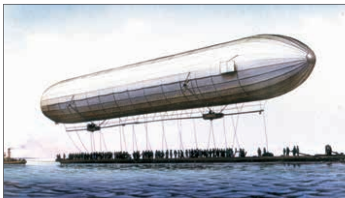
Das erste Zeppelin-Luftschiff LZ 1 (1900) wird vorbereitet für eine Fahrt. Die Luftschiffhalle befand sich, zweckmäßigerweise, auf dem Wasser des Bodensees. Der Schlepper zog das Schiff aus der Halle.
