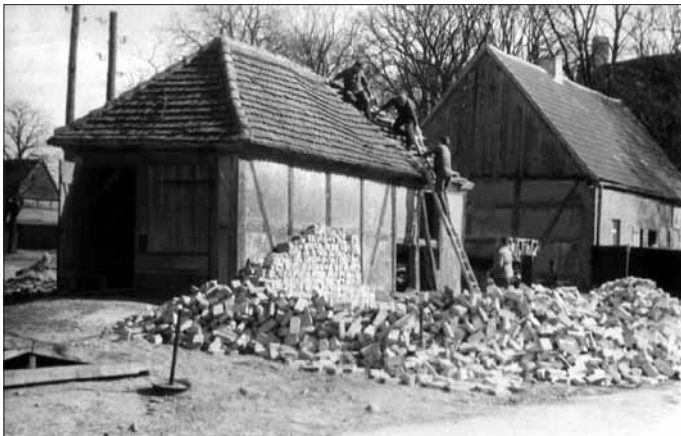
Abriss des alten Feuerwehr-Gerätehauses 1970
