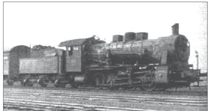
Belgische Güterzuglok der Baureihe „81“ (preuß. G. 81.1/DR-BR 55). Charakteristisch für belgische Lokomotiven war die besondere Schornsteinform.
