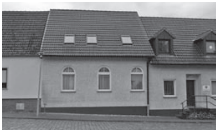
Das ehemalige jüdische Bethaus in der Sandkuhlstraße, gegenüber der Feuerwehr
