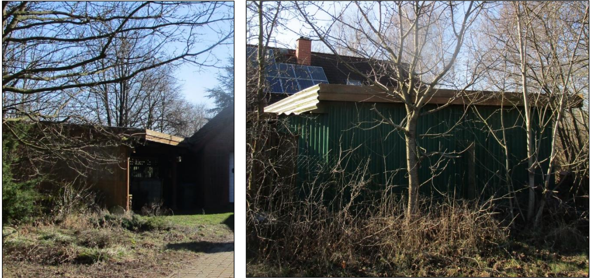
Abbildung 10 Carport, das für die Vorhabenrealisierung zurückgebaut werden soll
