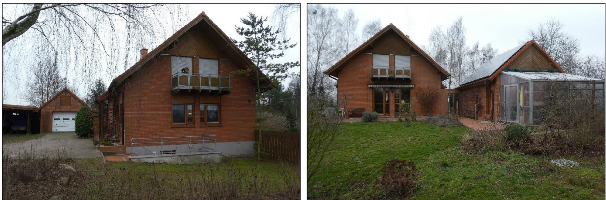
Abbildung 6 Gebäudebestand innerhalb des Geltungsbereiches zum vBP Nr. 2 „Tischlereiwerkstatt Schwennenz“
